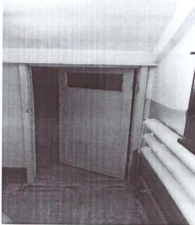
Тамбур 1 этажа был очищен от инвентаря техперсонала
